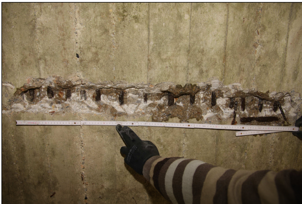
Obr. č. 15 - Detailní pohled do sondy SNK2, provedené pro ověření hlavní tahové výztuže ve spodním líci NK, v pravé části
