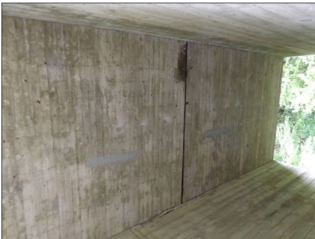
Obr. č. 10- pohled na nosnou konstrukci a lokální průsak v pravé části v dilatační spáře
